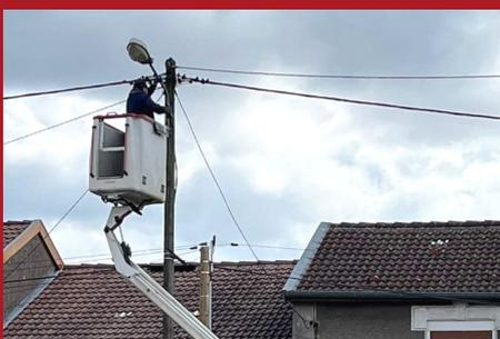
*L'éclairage public de Bras passe en leds. Cent huit points lumineux viennent d'être remplacés et six points ajoutés, dont l'éclairage du pont du canal.*
